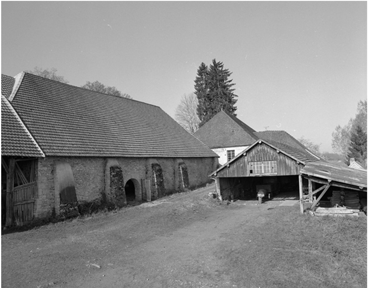
Vue de la halle à charbon.
