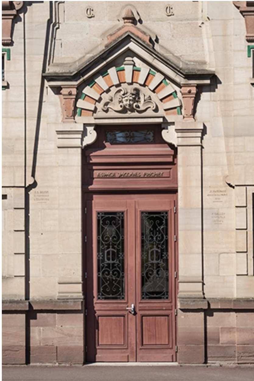
Façade sur la rue de Grammont, partie centrale, portail, détail.
