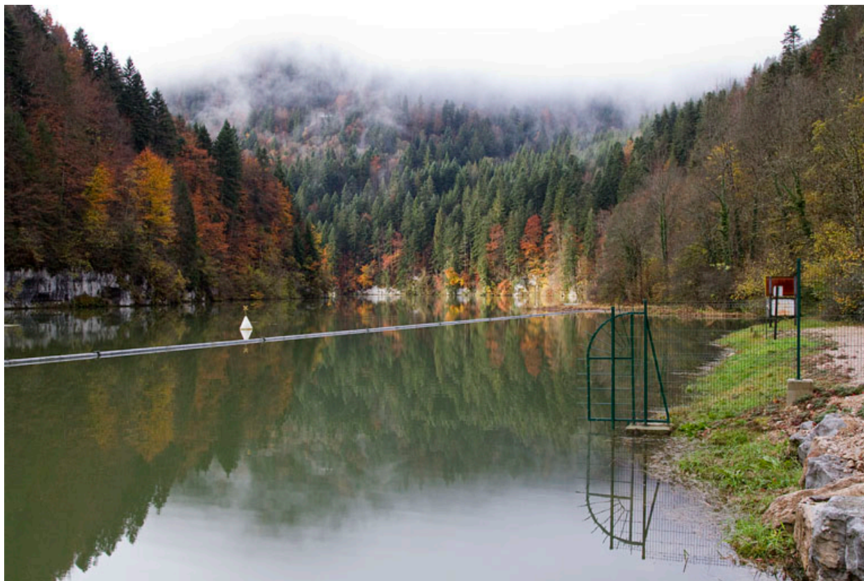
Le bassin de retenue, depuis le nord-est.
