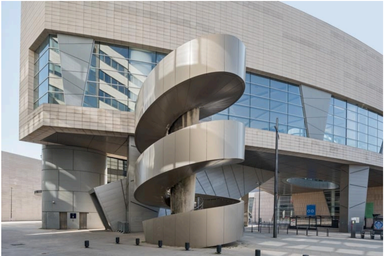
Extrémité du corps d'entrée, vue de l'ouest.
