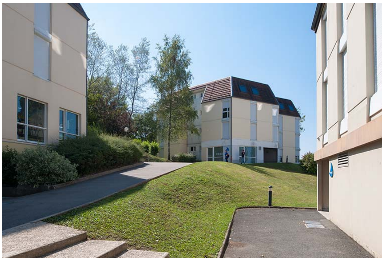
Les bâtiments d'hébergement.
