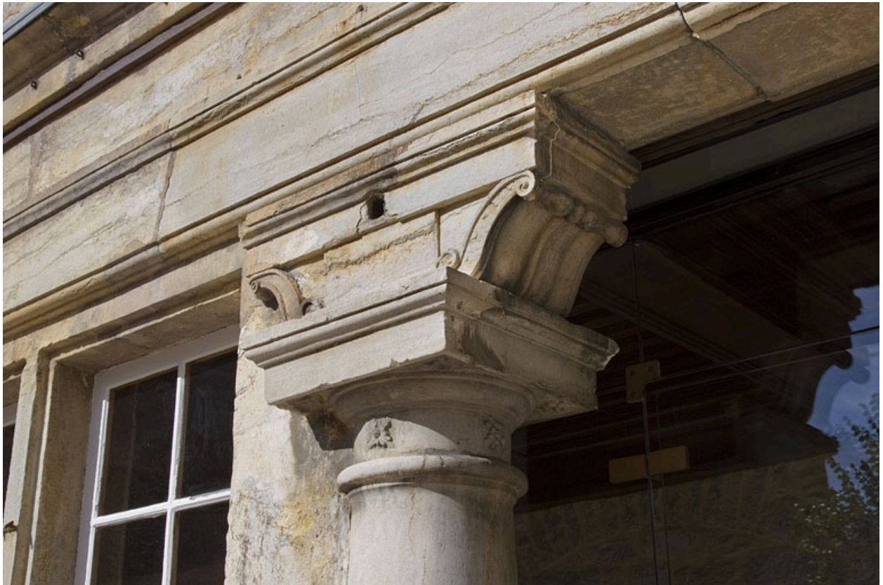
Logis principal, façade postérieure : détail d'une zapata du portique, de trois quarts droit.
