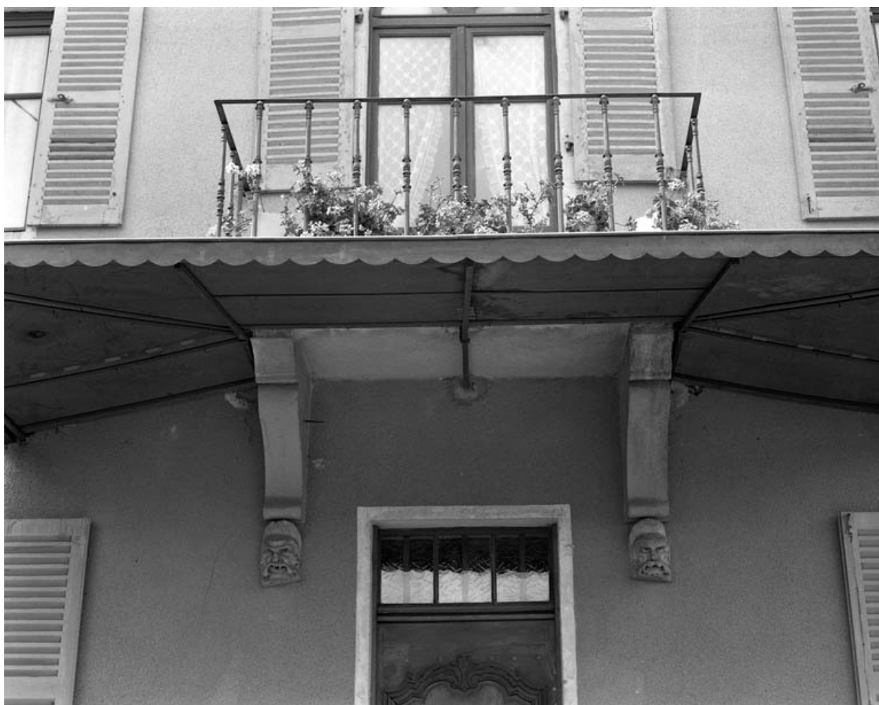
Détail du balcon.
