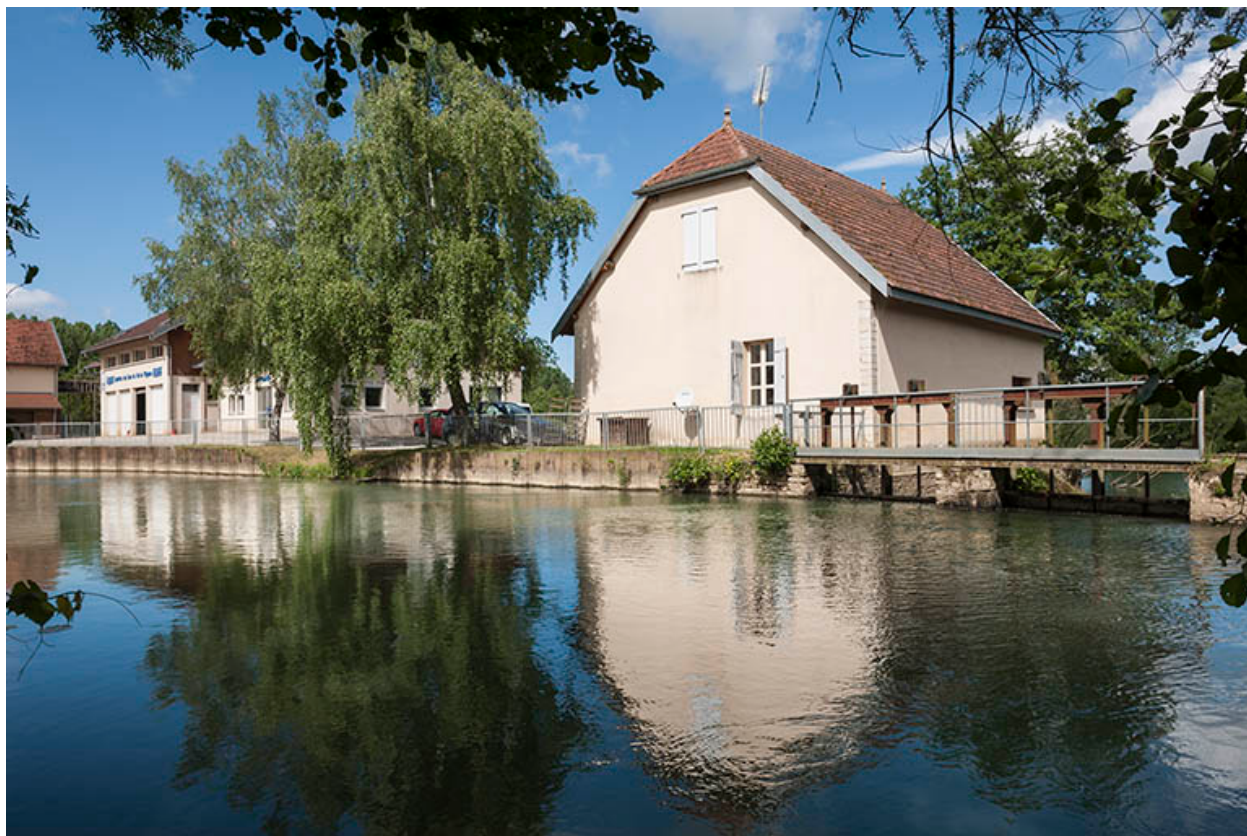
Vue depuis le début du canal d'amenée.
