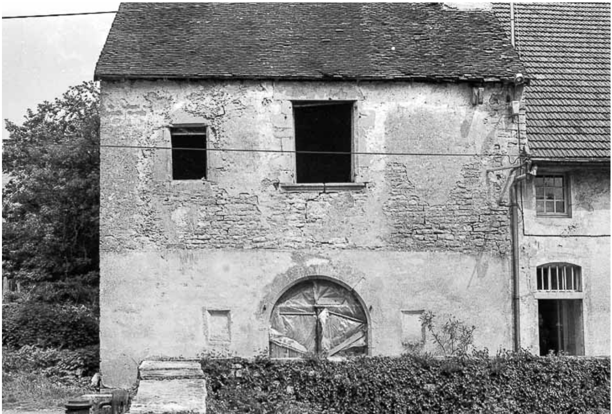
Maison attenante au presbytère : façade postérieure.
