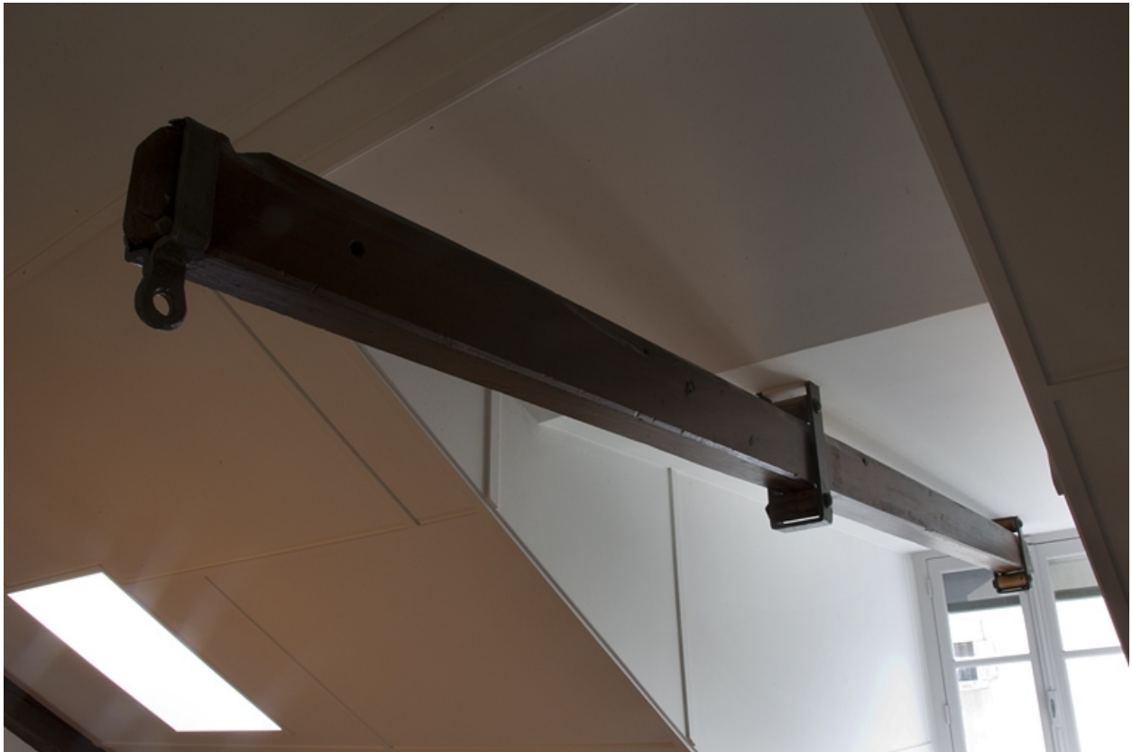
Aile droite, intérieur : détail d'un monte-charge.
