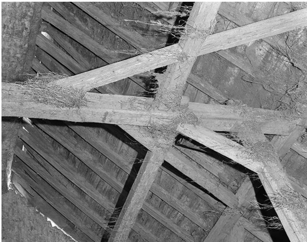
Poteau de charpente latéral d'une ferme.
