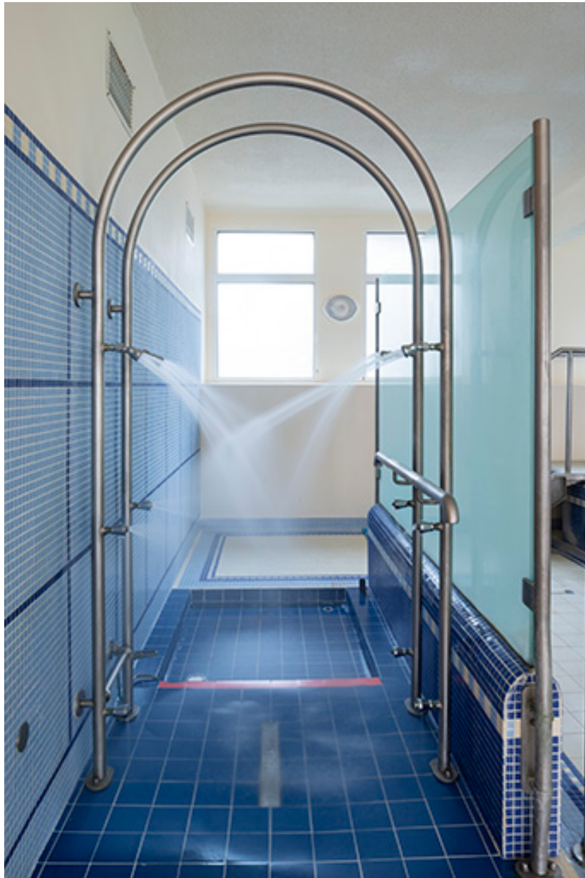
Bâtiment d'Hygie, extension nord, rez-de-chaussée.
