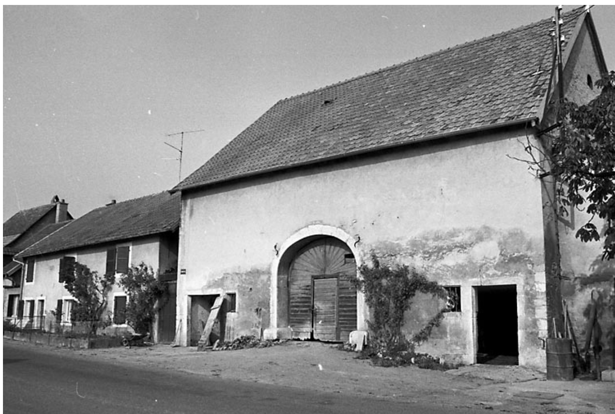
Taillecourt : ferme située Grande Rue.
