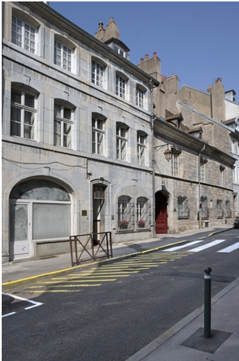
Vue d'ensemble du logis sur rue, de trois quarts gauche.
