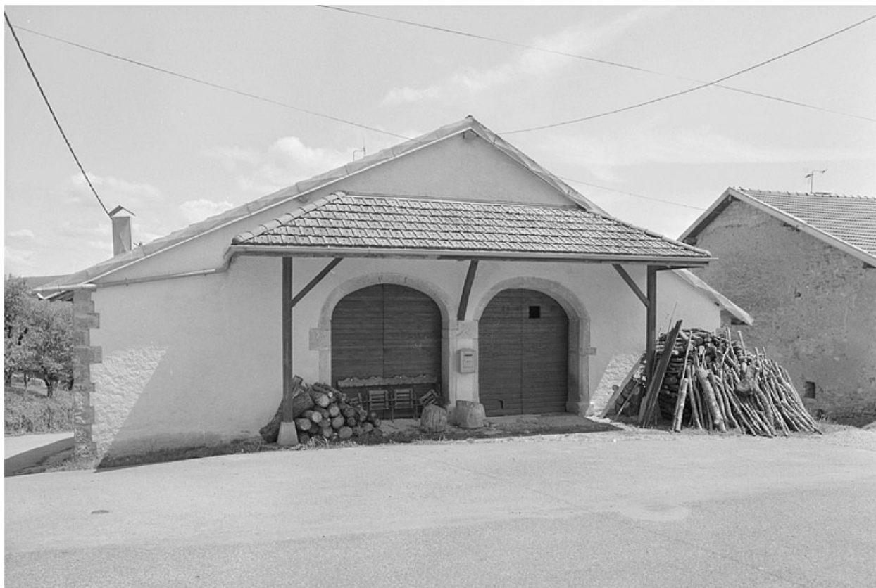
Façade postérieure avec granges hautes.
