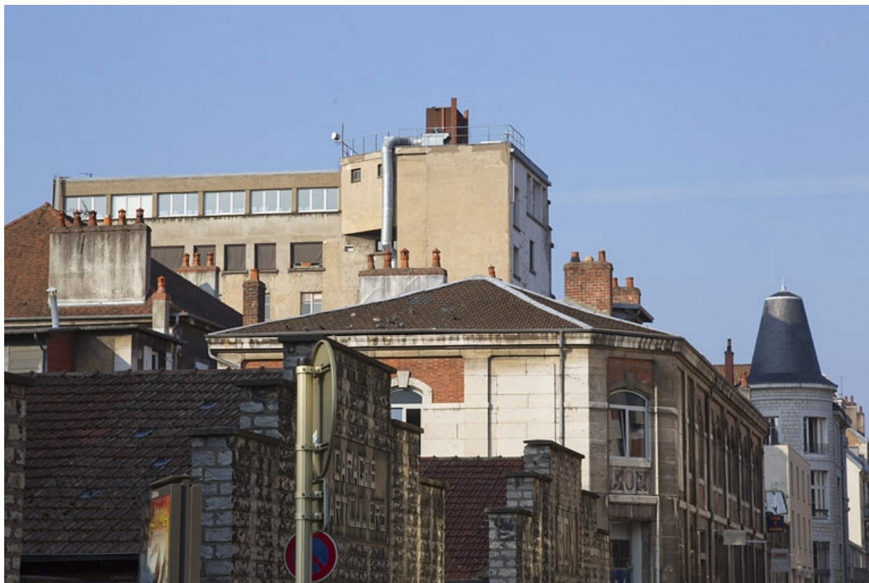
Façade postérieure : vue éloignée.
