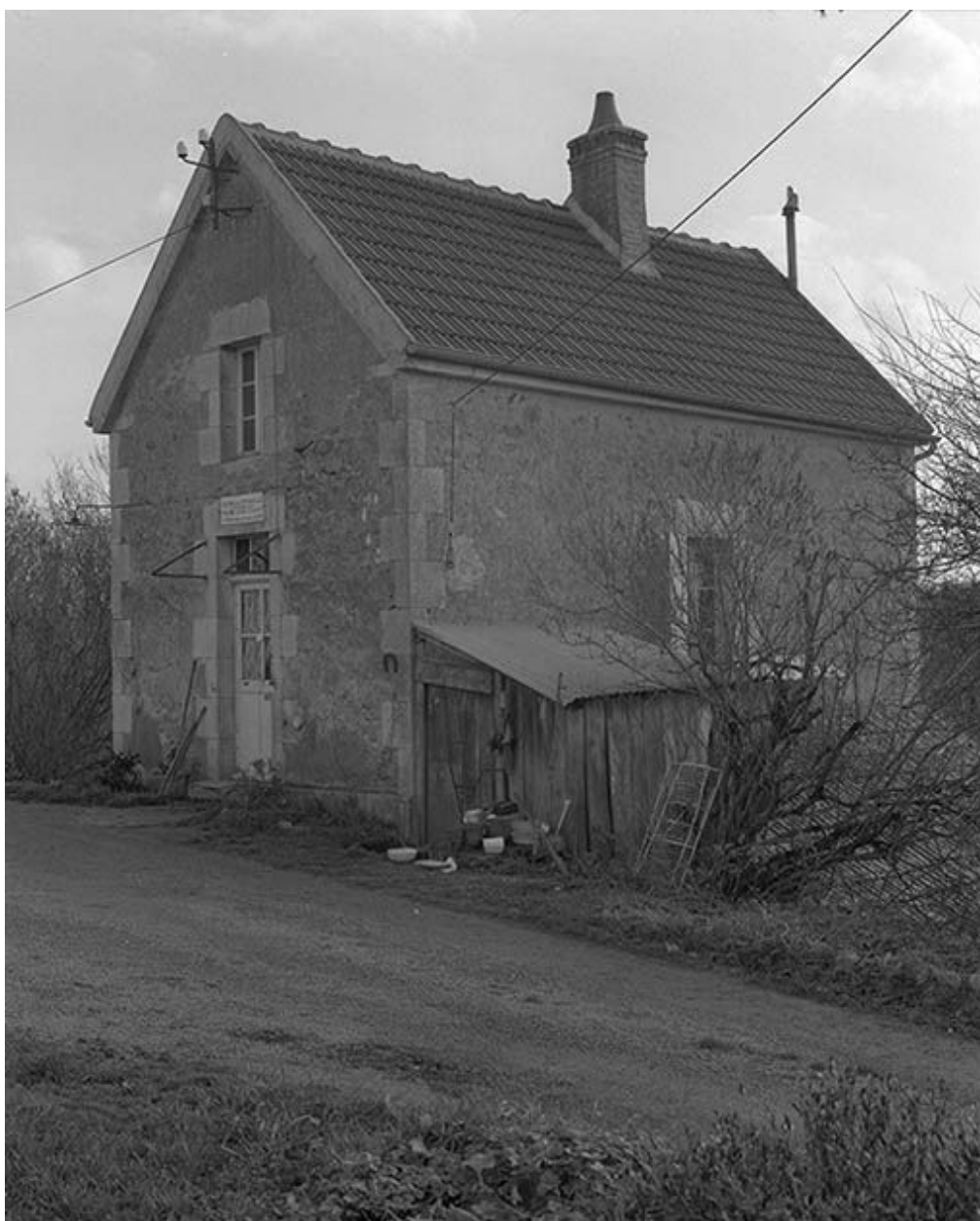
La maison d'éclusier.
