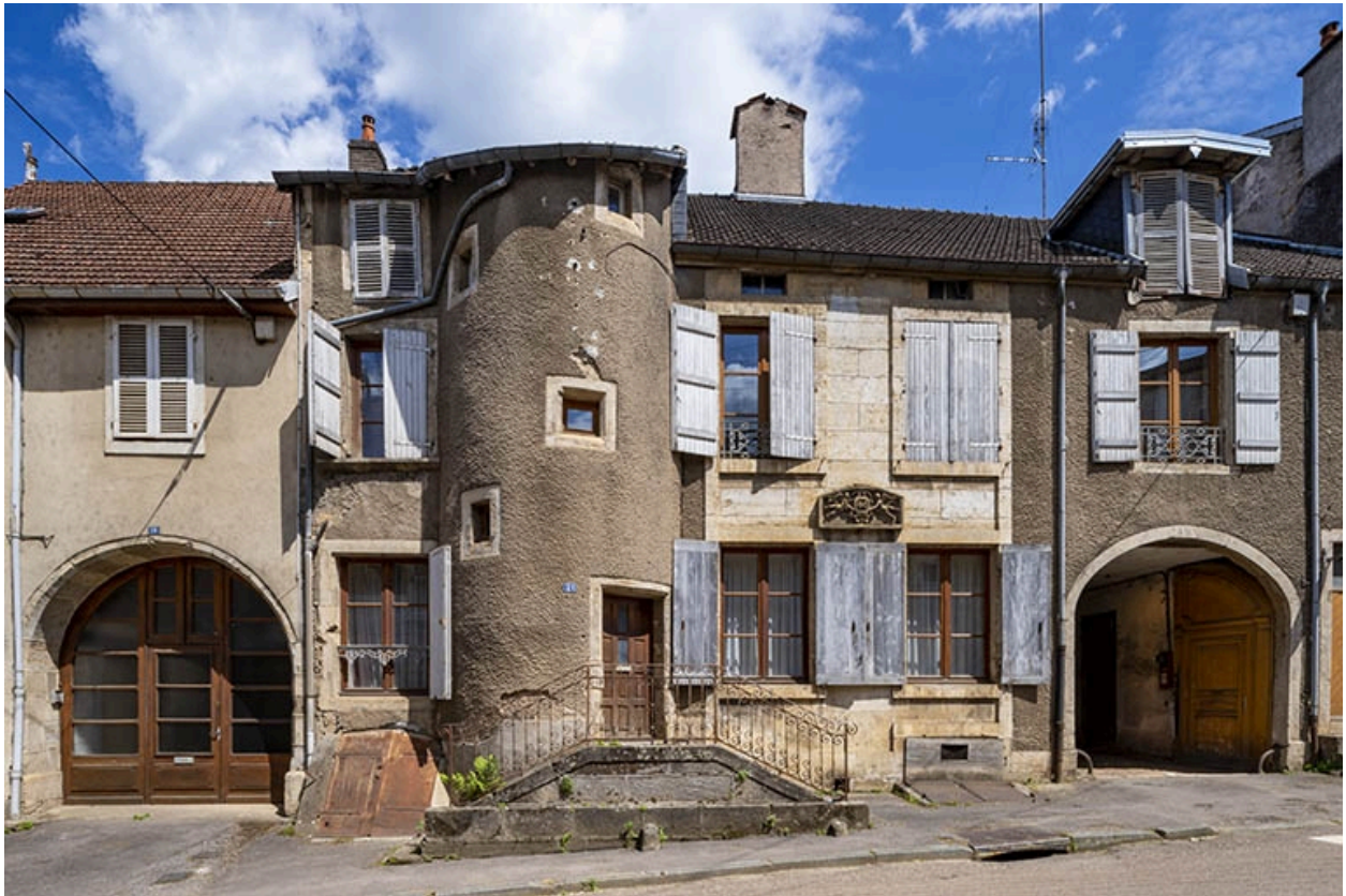
La façade antérieure depuis la rue.
