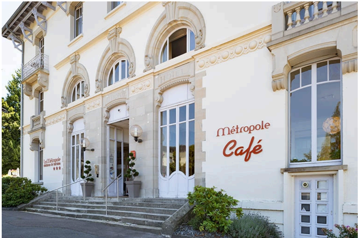
Façade nord, vue de trois quarts, détail.
