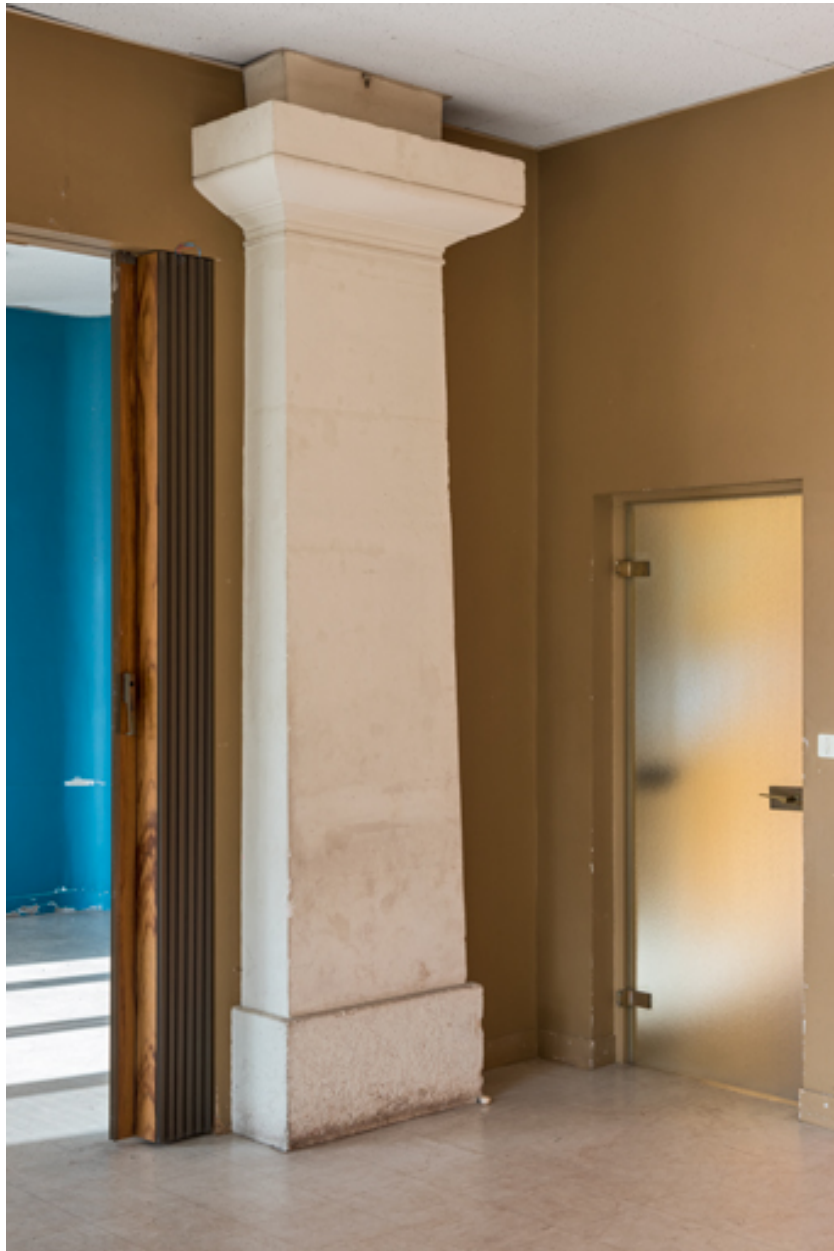
Ancienne halle au blé : pilier.
