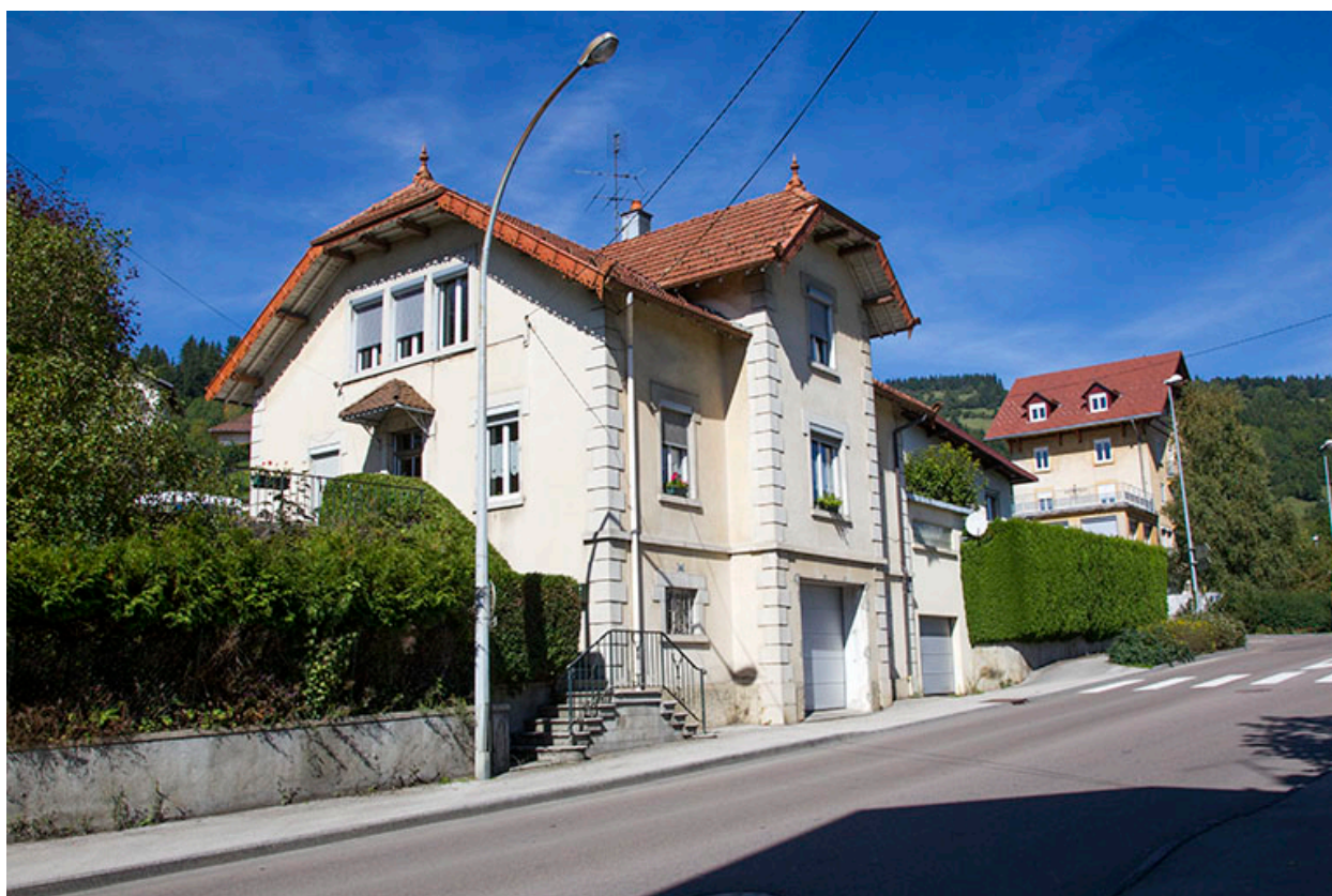
Façades antérieure et latérale gauche.
