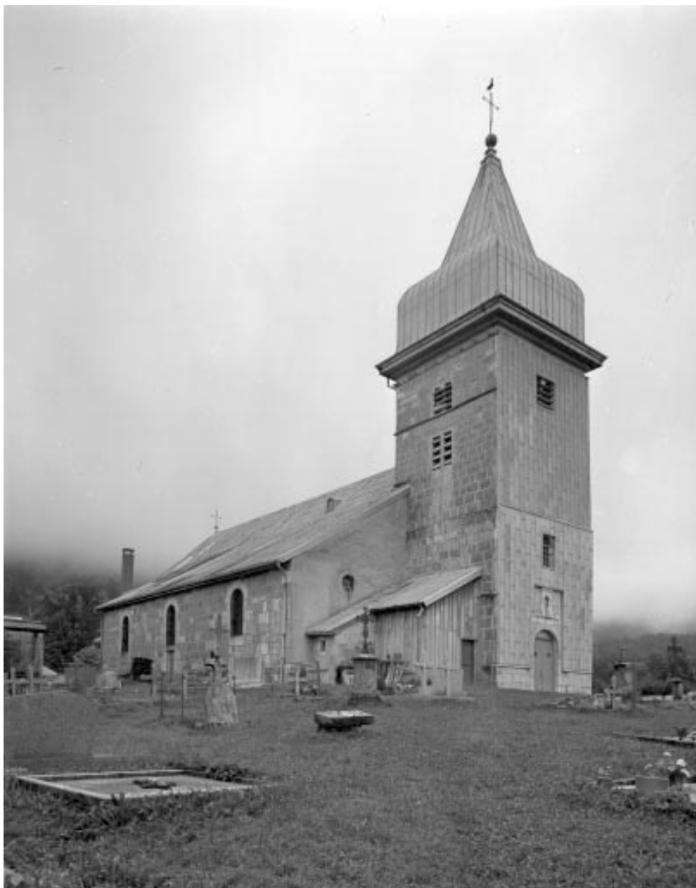
Extérieur : façade occidentale et face nord.
