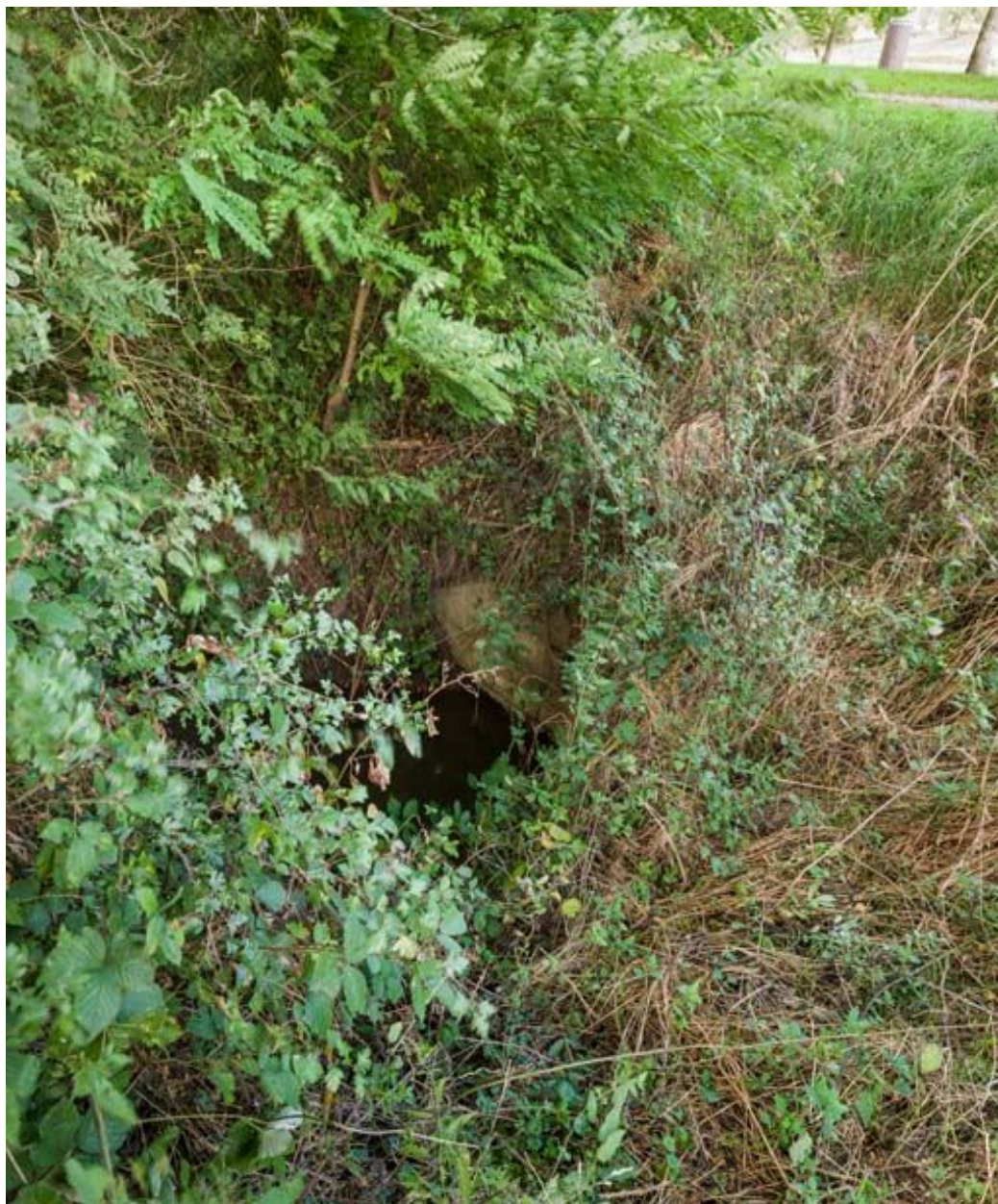
Vue de l'aqueduc.
