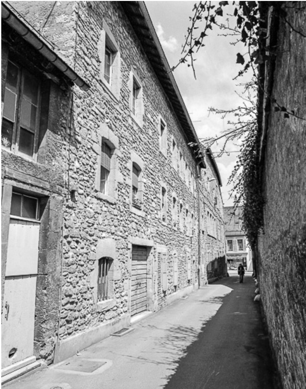
Vue de la rue Thiers donnant sur la rue de la République.
