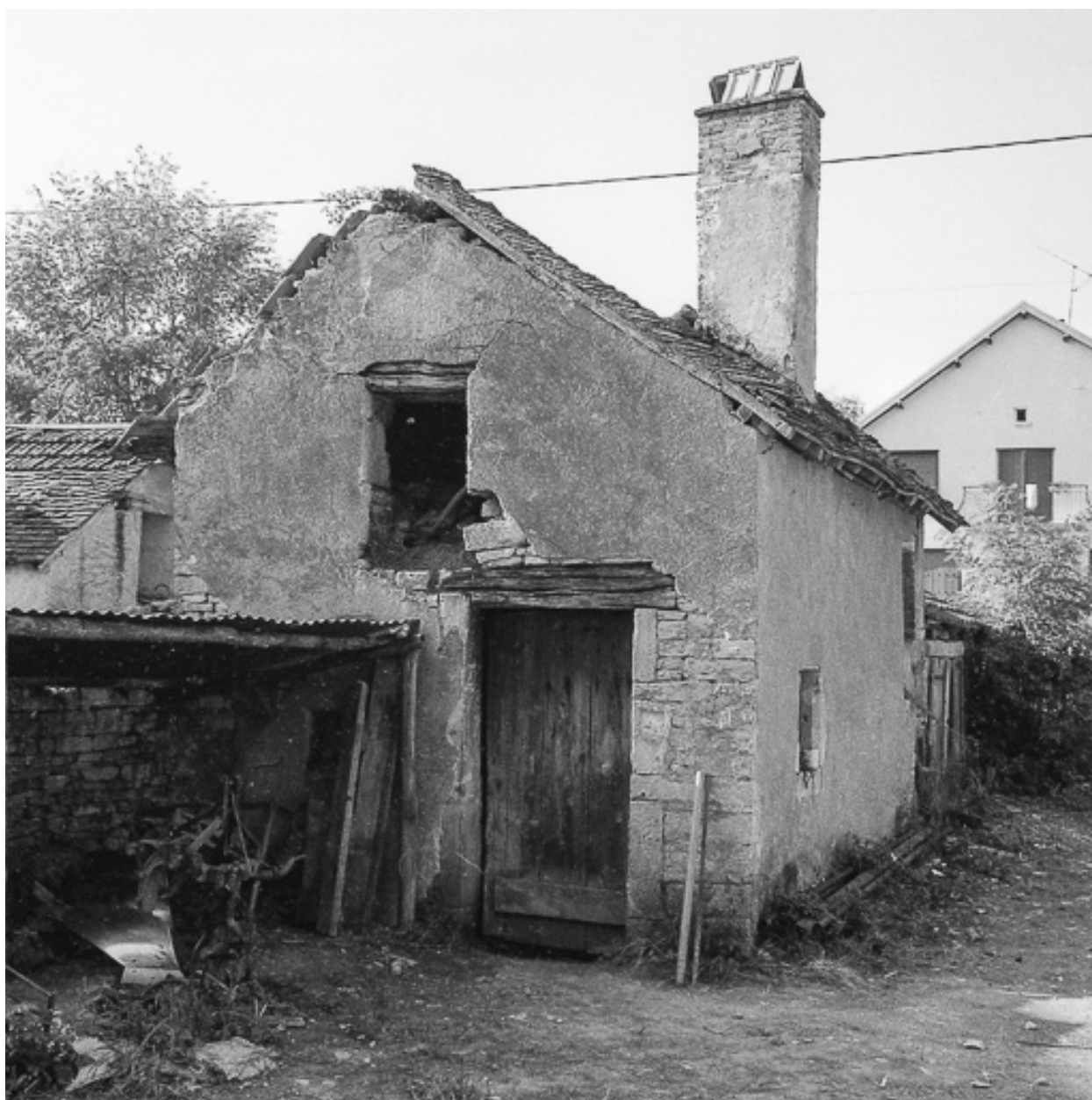
Vue du four depuis la cour.
