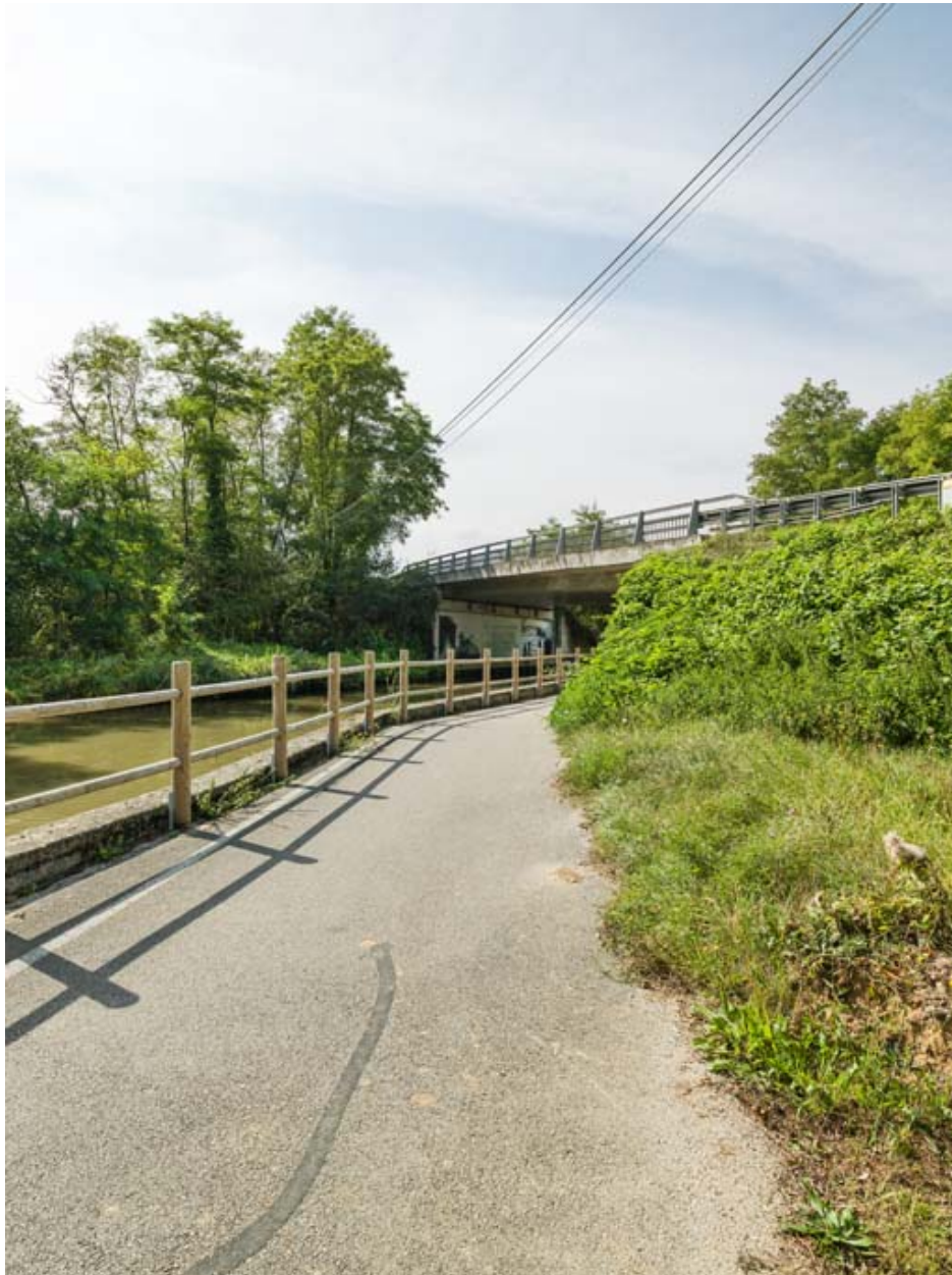
Vue d'ensemble du pont et du canal.
