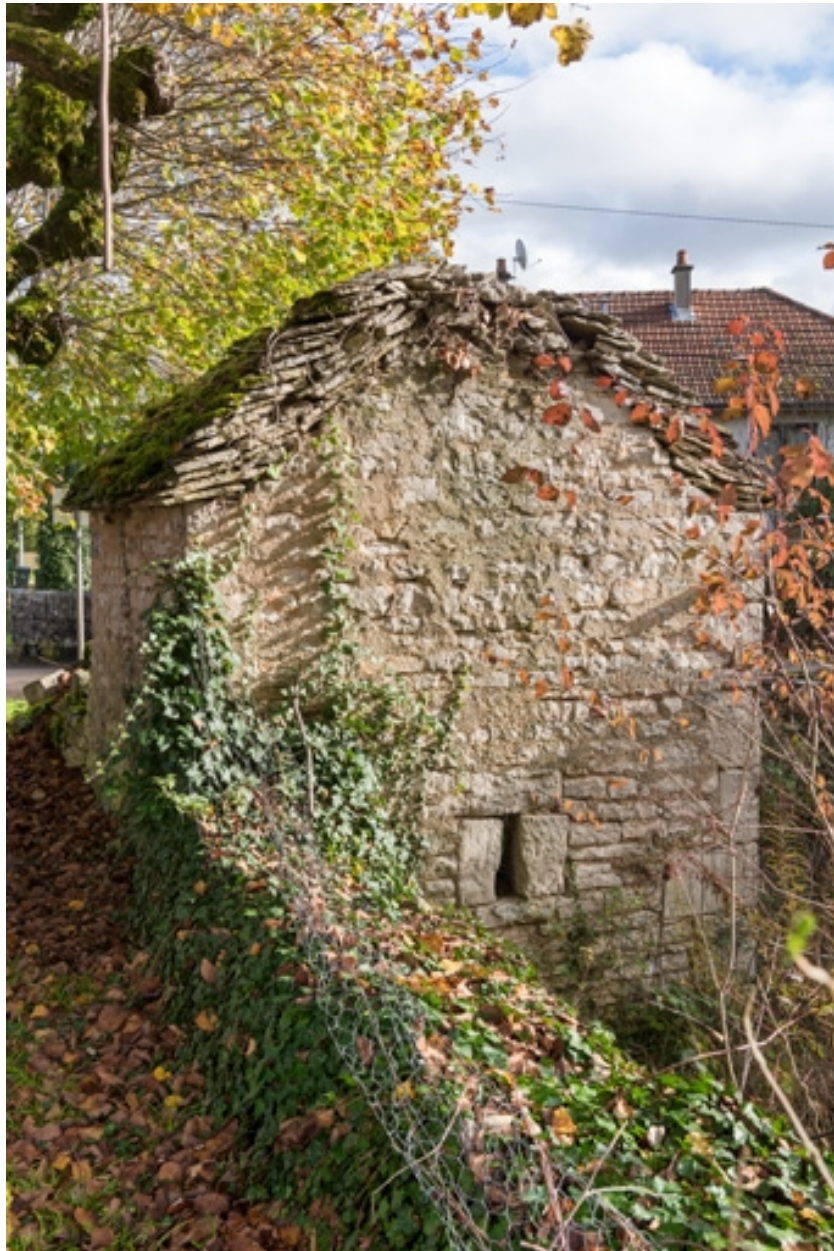
Vue de la façade ouest.
