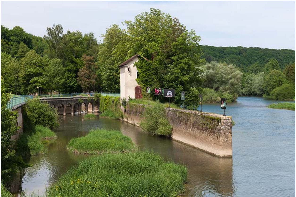
L'ancien canal de fuite et le transformateur.
