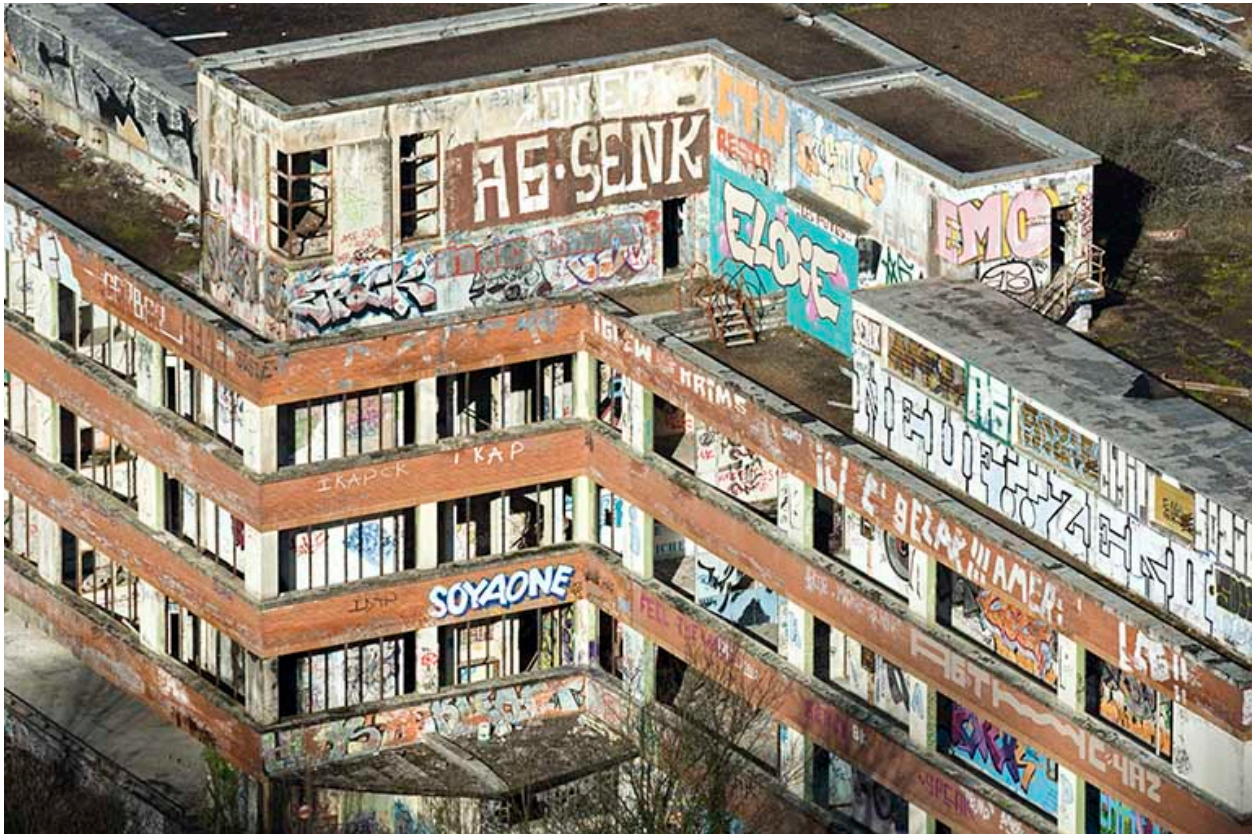
Etat en 2016. Usine A : vue plongeante sur un décrochement de la façade sud des ateliers d'étirage et filature tergal et nylon.
