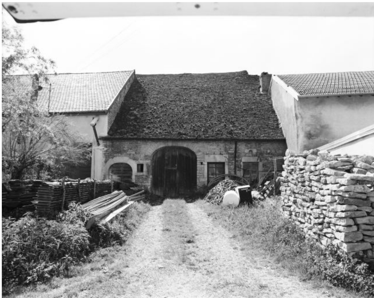
Ferme située route de la Chapelle : façade antérieure.
