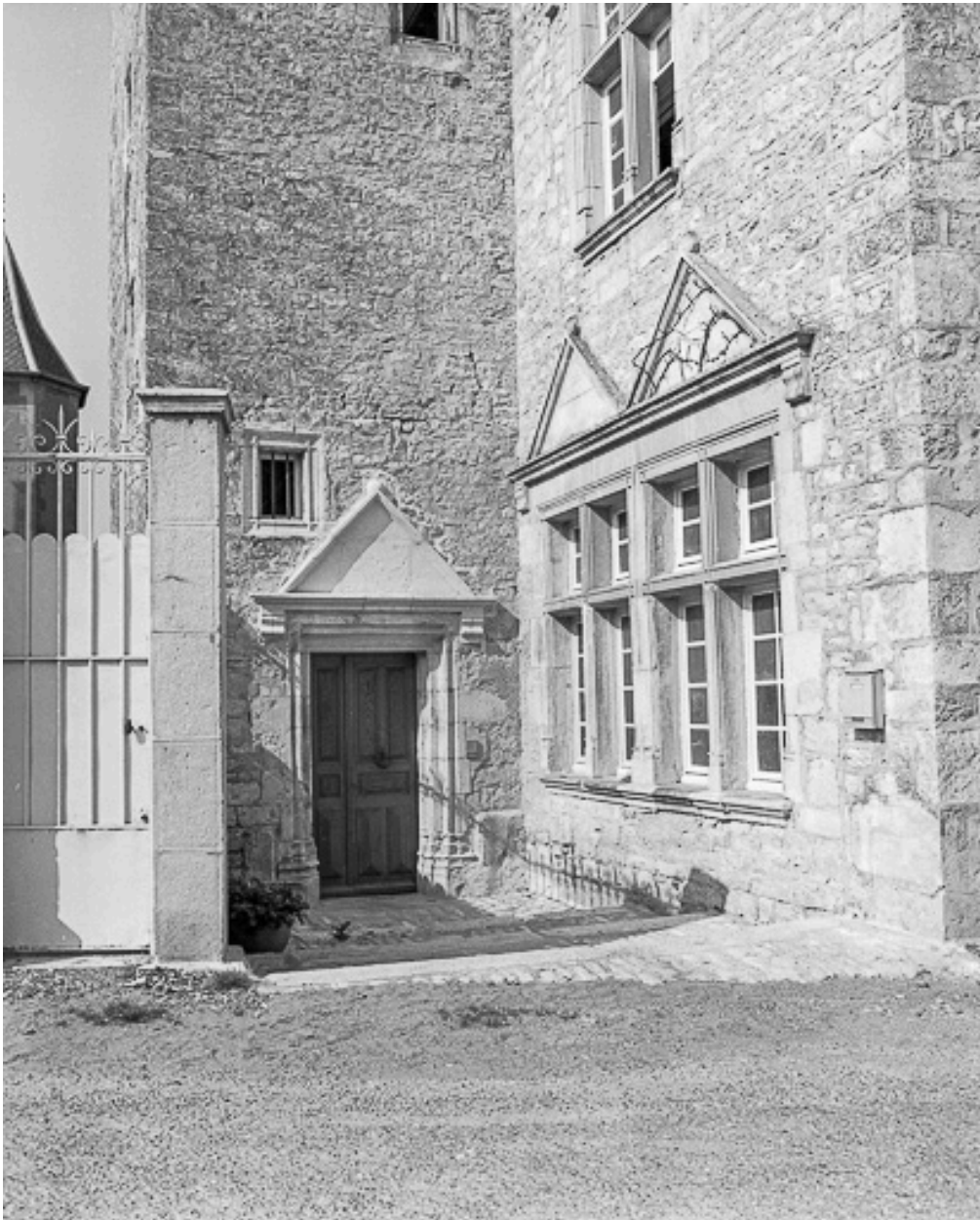
Entrée de l'escalier en vis.
