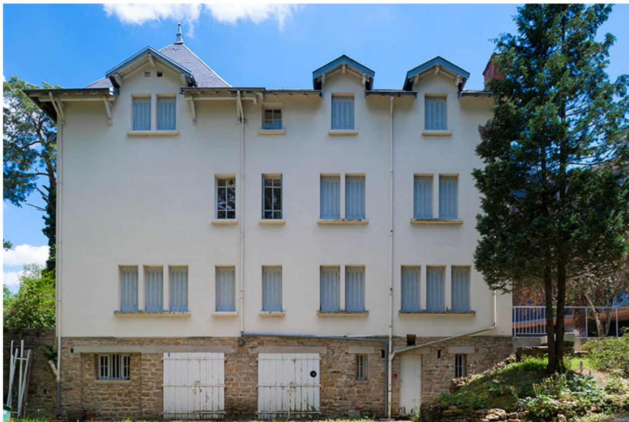
Chalet Colette : façade postérieure de l'aile ouest.
