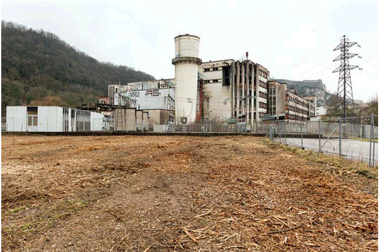
Etat en 2016. Usine A : vue d'ensemble de l'extrémité orientale, depuis l'emplacement de l'atelier de fabrication oriental (Z) détruit.
