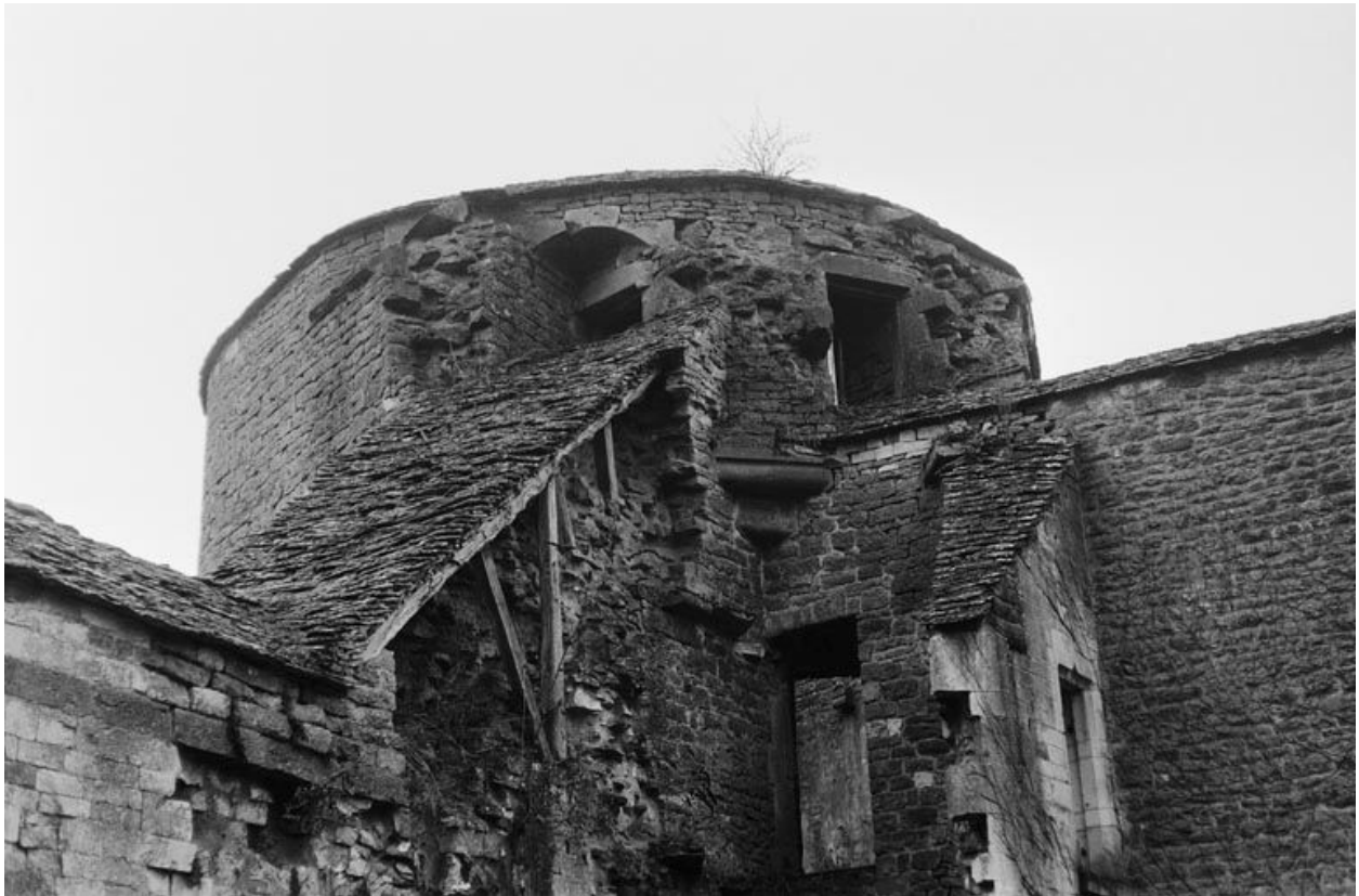
Enceinte : tour d'angle avec tourelle. Détail : le sommet de la tour (photo prise en 1969).
