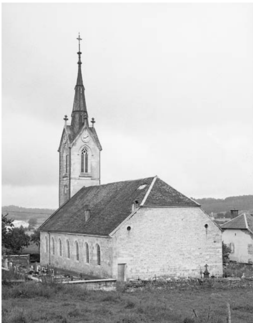
Extérieur : chevet et face latérale droite.
