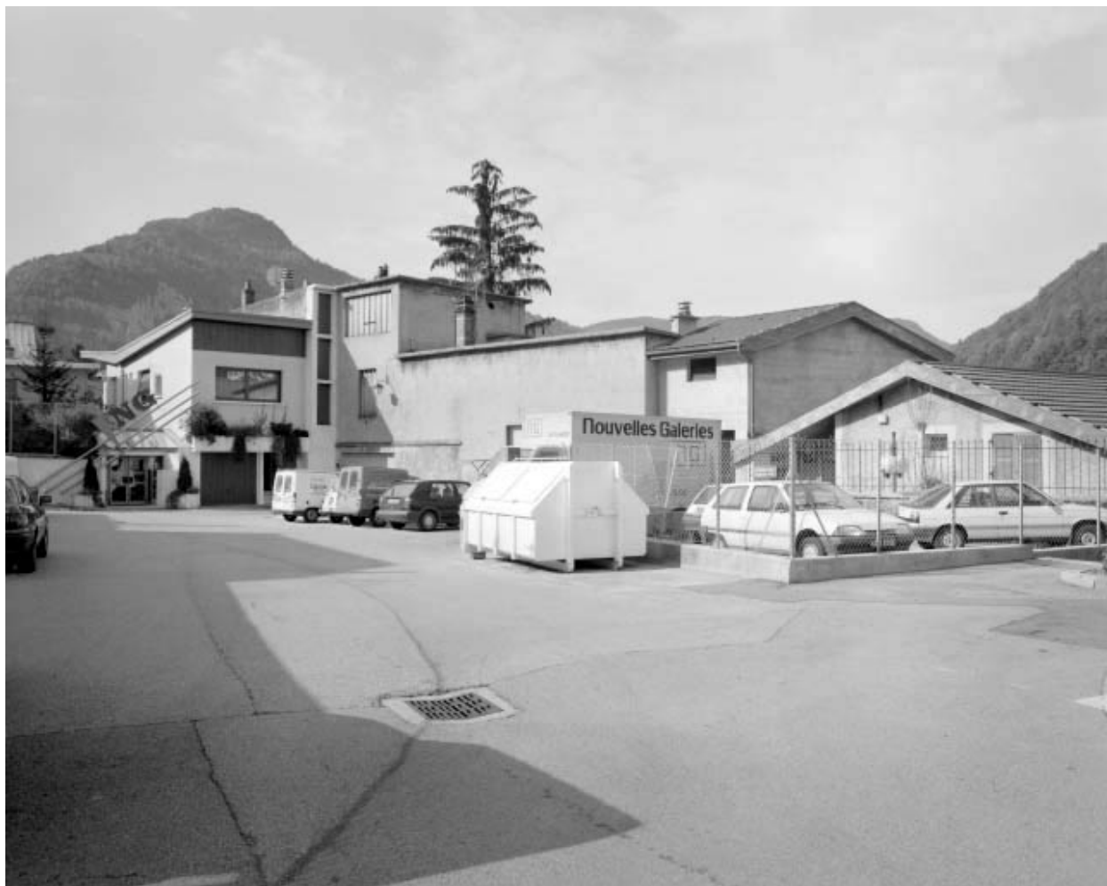
Façade orientale des bâtiments.
