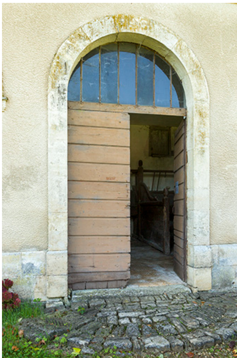
Ecurie, façade nord-est : la porte.
