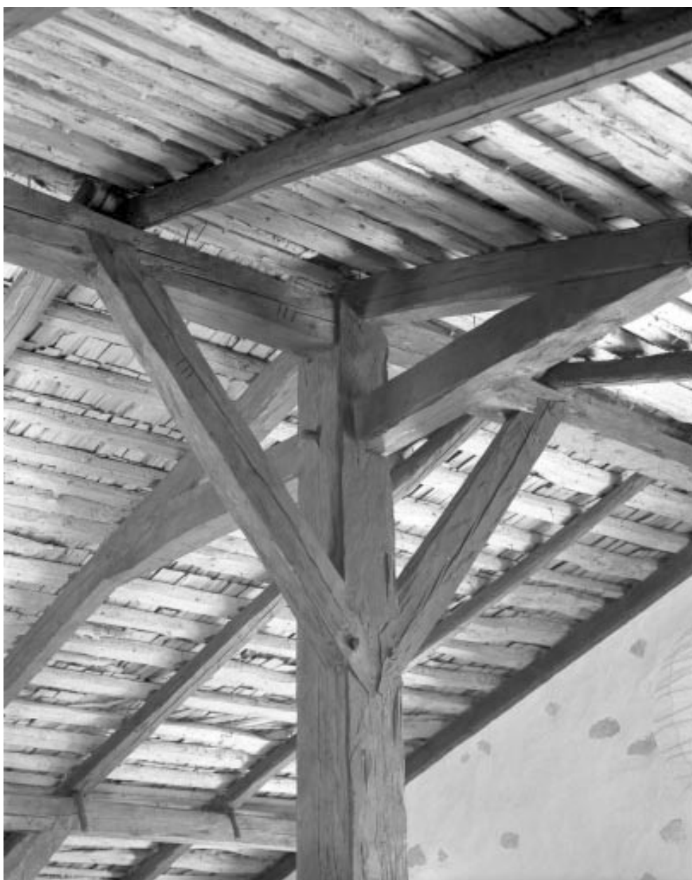
Détail de la charpente : assemblage du poteau avec la faîtière.
