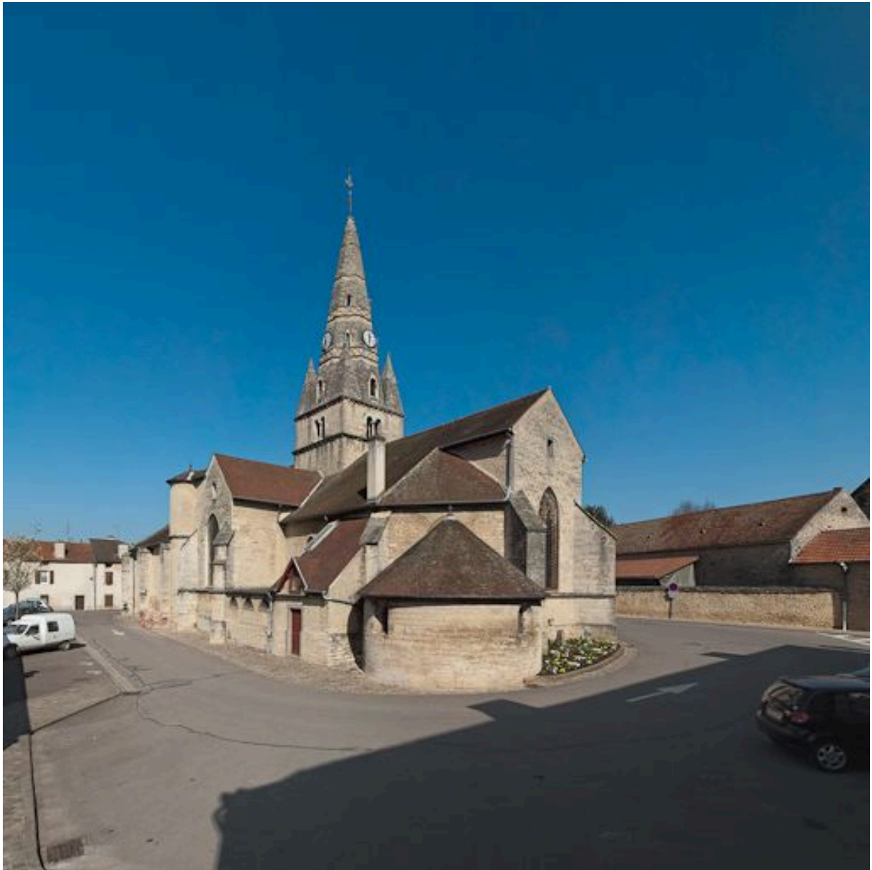
Vue d'ensemble côté chevet.
