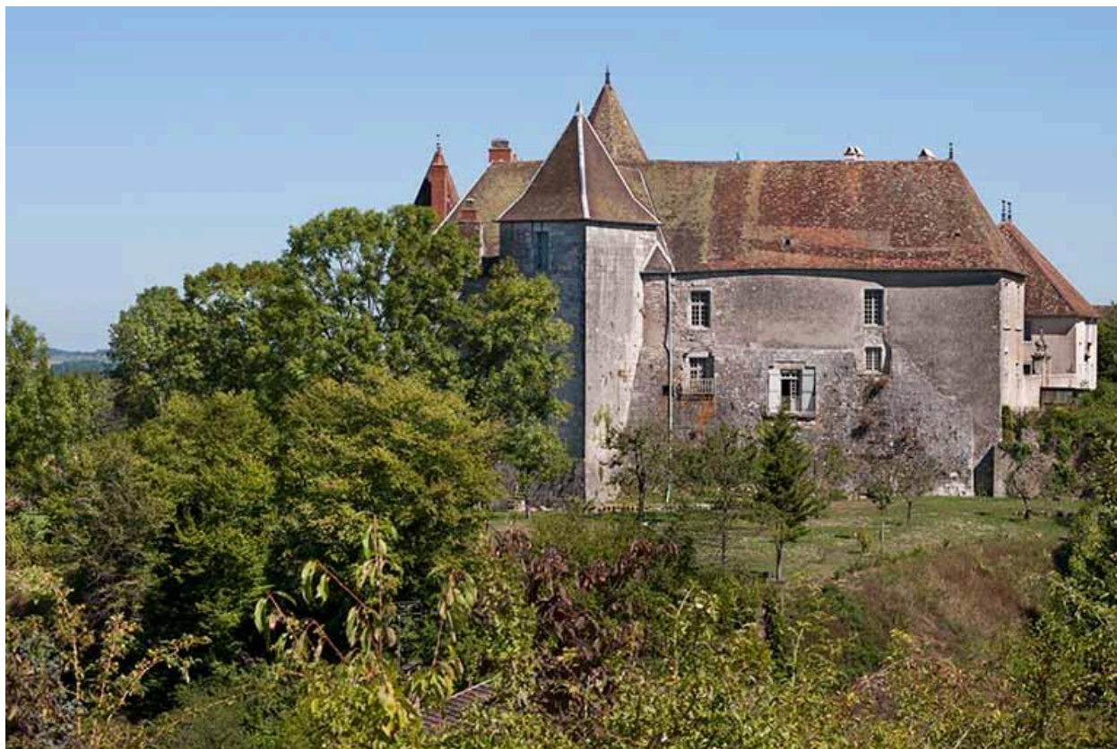
Vue ouest du château
