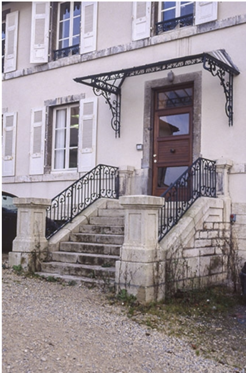
Perron du bâtiment des bureaux.
