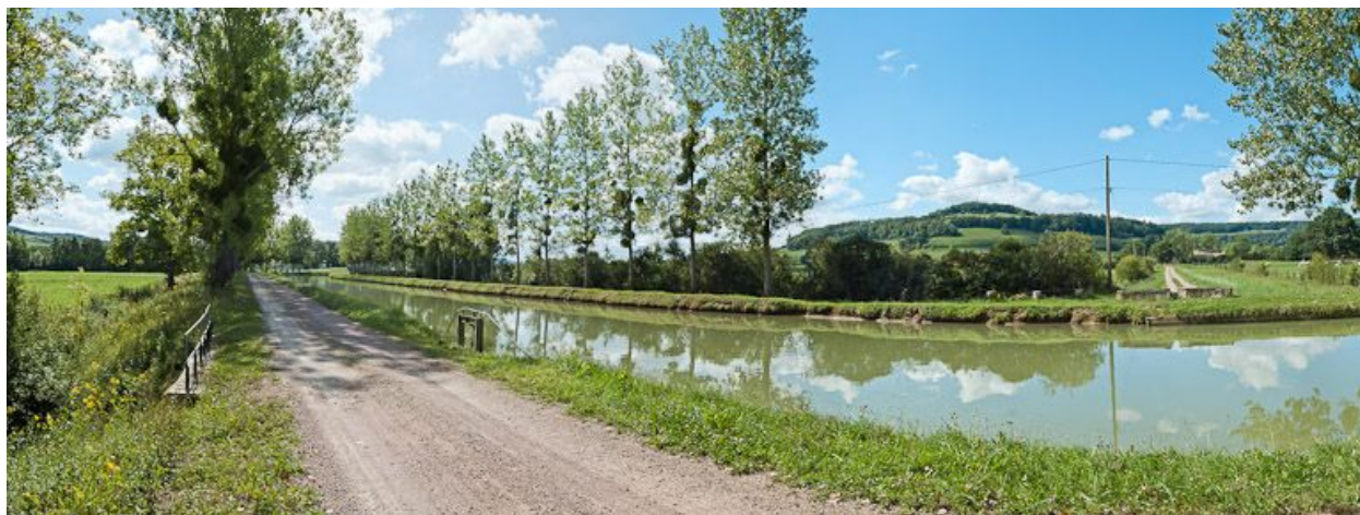
Vue du déversoir.
