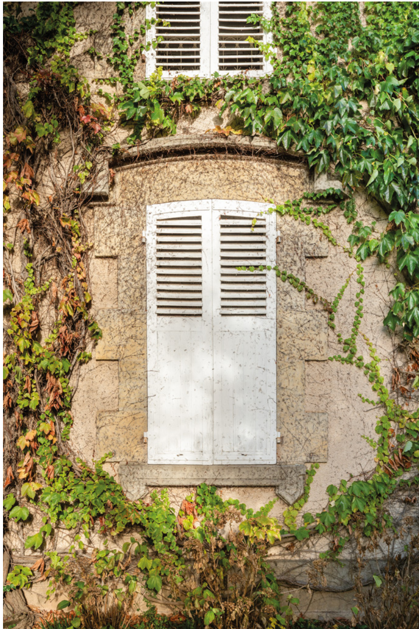
Logis. Fenêtre sur le pignon sud.
