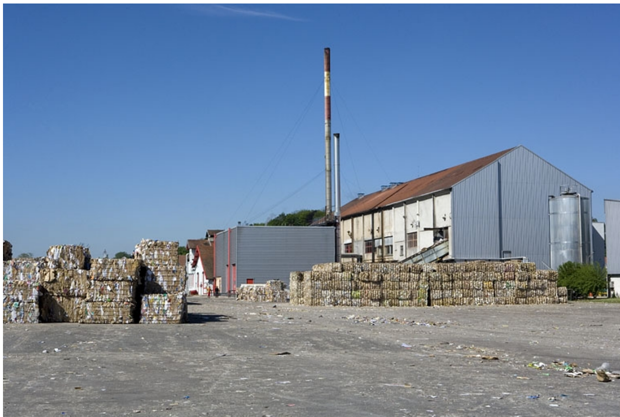
Aire des matières premières et atelier de trituration depuis le nord-est.
