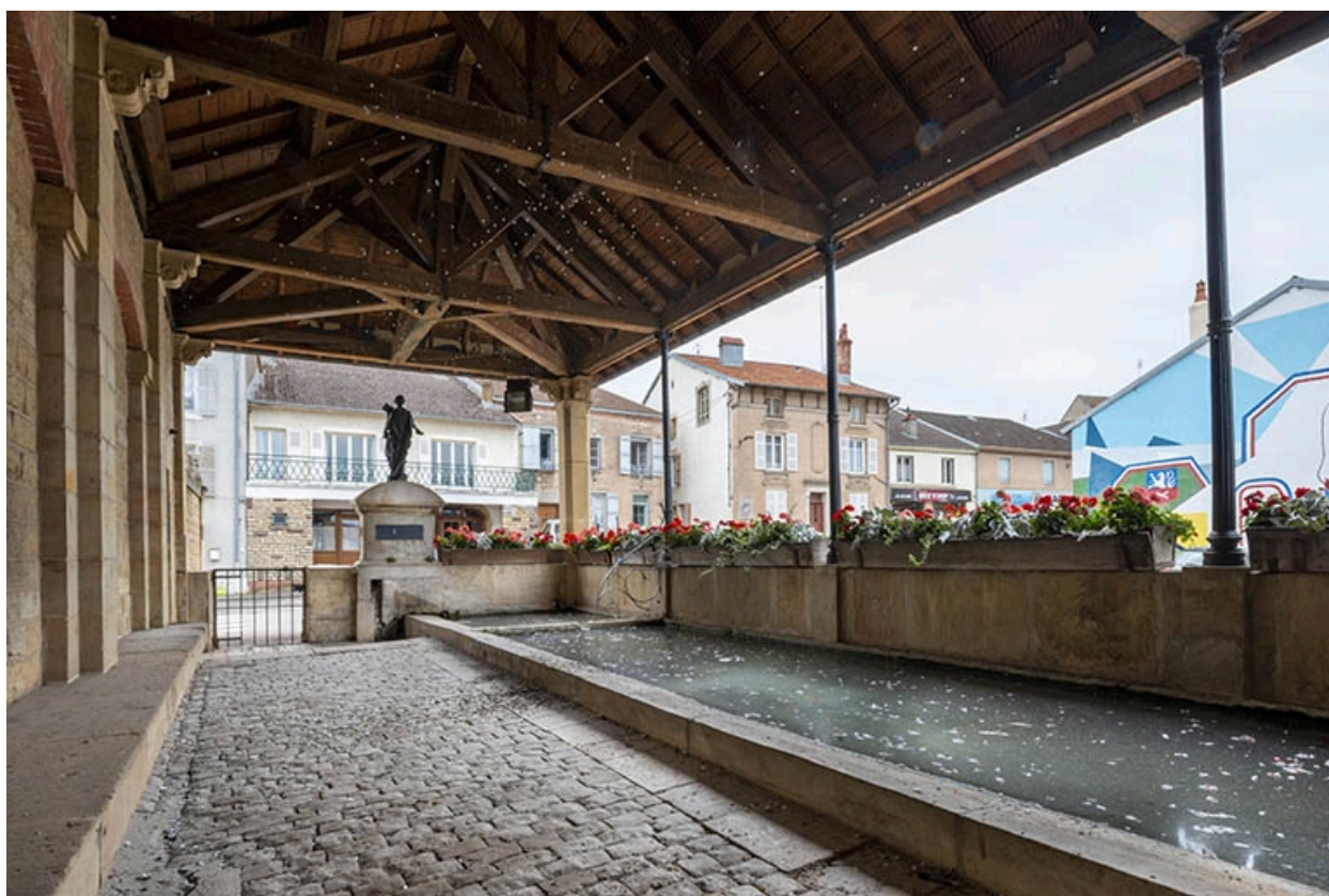
L'intérieur du lavoir, depuis le fond.
