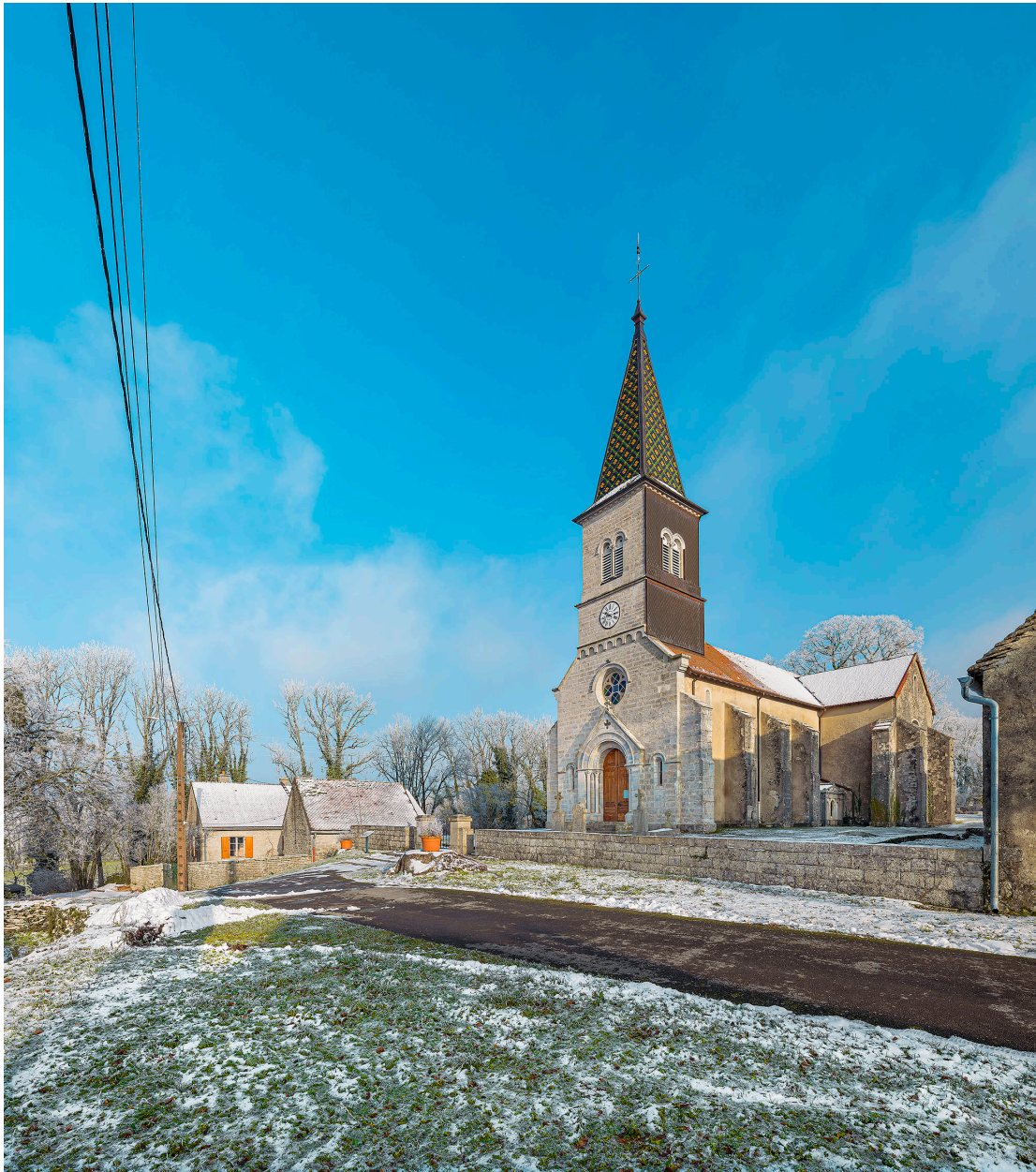
Vue d'ensemble de l'église, dans son environnement.
