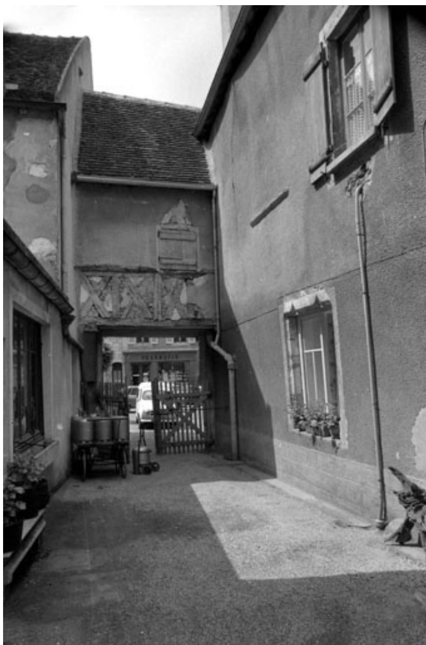
Détail passerelle couverte au-dessus de l'impasse.
