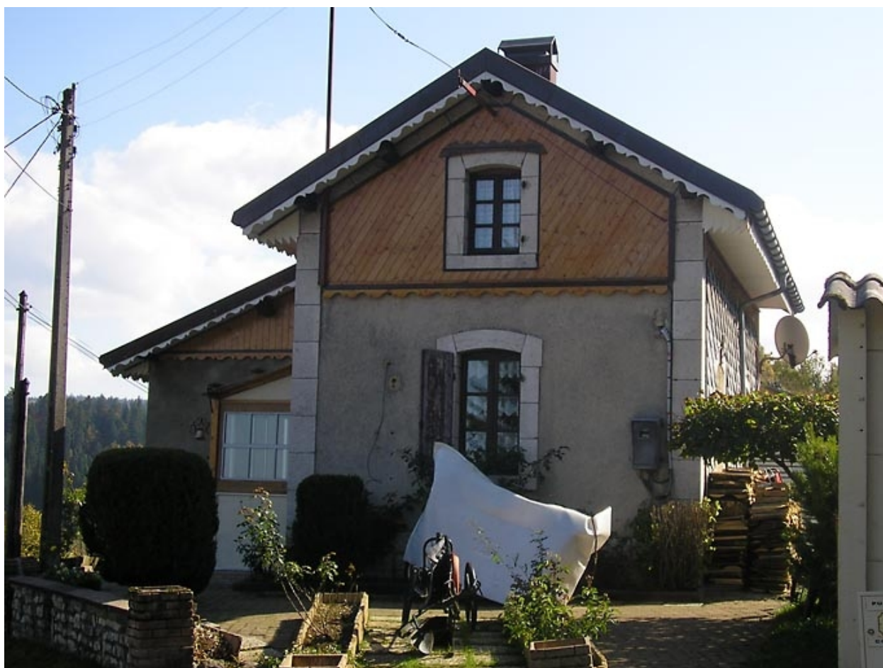
Vue latérale de la façade ouest.
