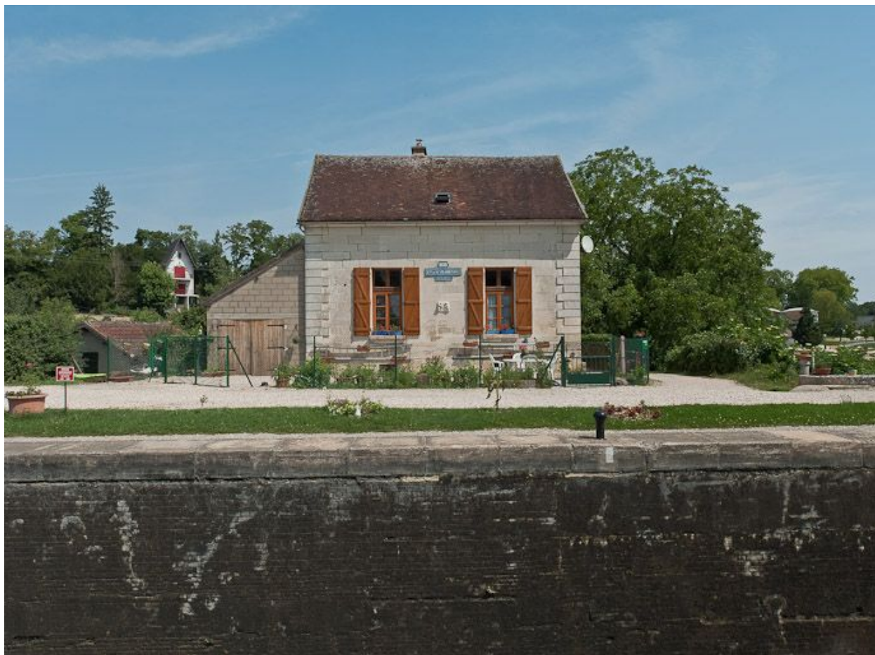
Vue de face de la maison éclusière.
