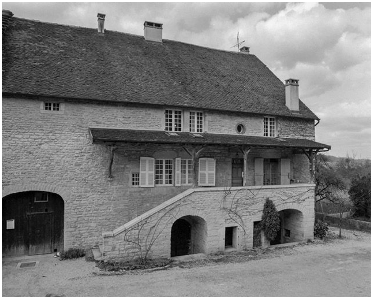
Façade antérieure de l'habitation.
